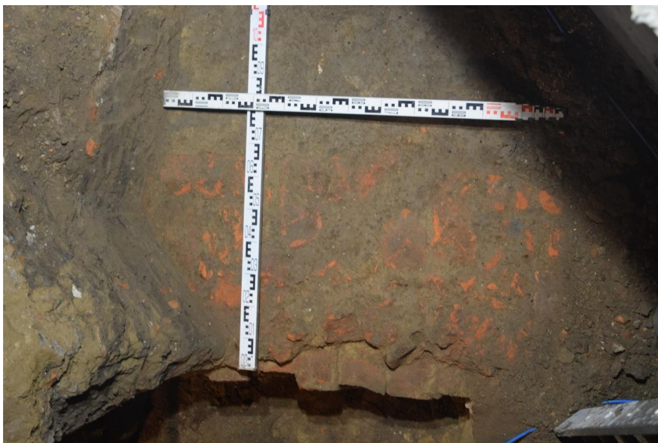
Fot. 24. Poziom konstrukcji ceglanej. Widoczne cegły wierzchnie mocno zniszczone.
