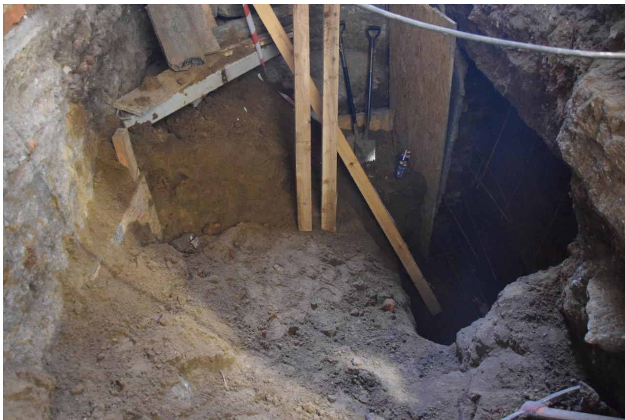
Fot. 19. POM 3 w trakcie podbijania fundamentów.
