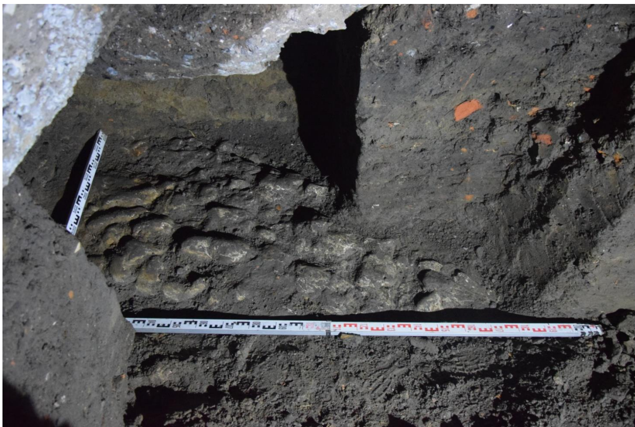
Fot. 38. Bruk w jednym z miejsc podbicia fundamentów.
