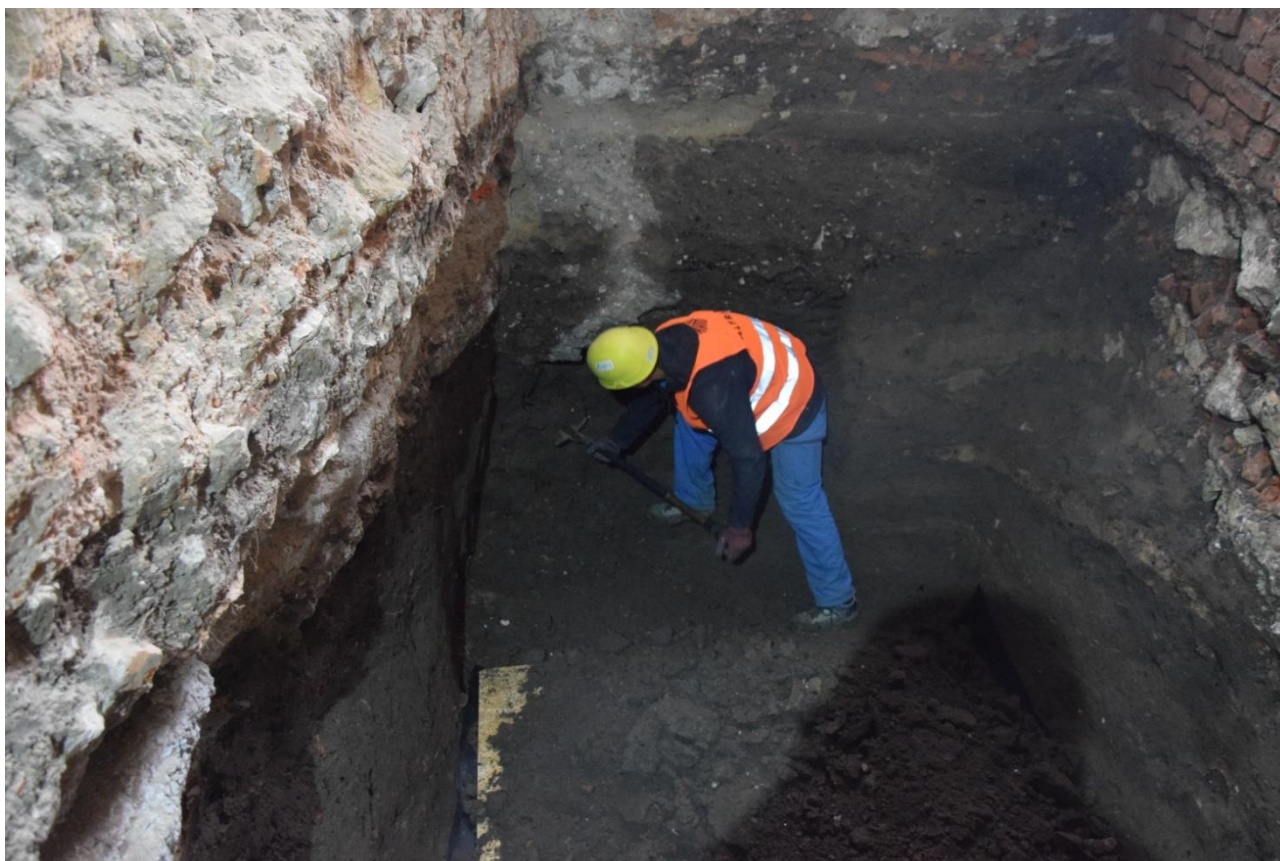
Fot. 37. Punktowe wybieranie ziemi w celu podbicia fundamentów.
