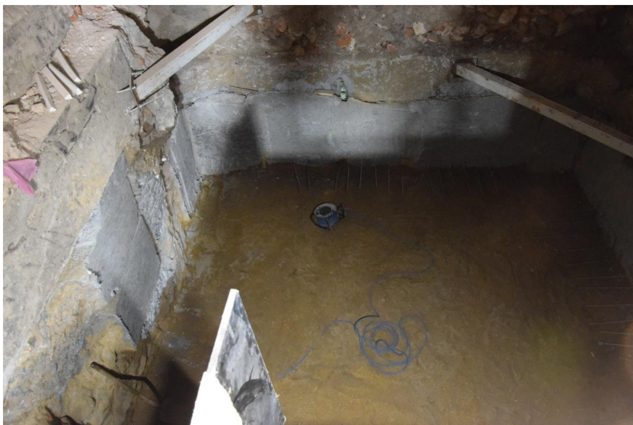
Fot. 28. POM 2 po zakończeniu podbijania fundamentów.
