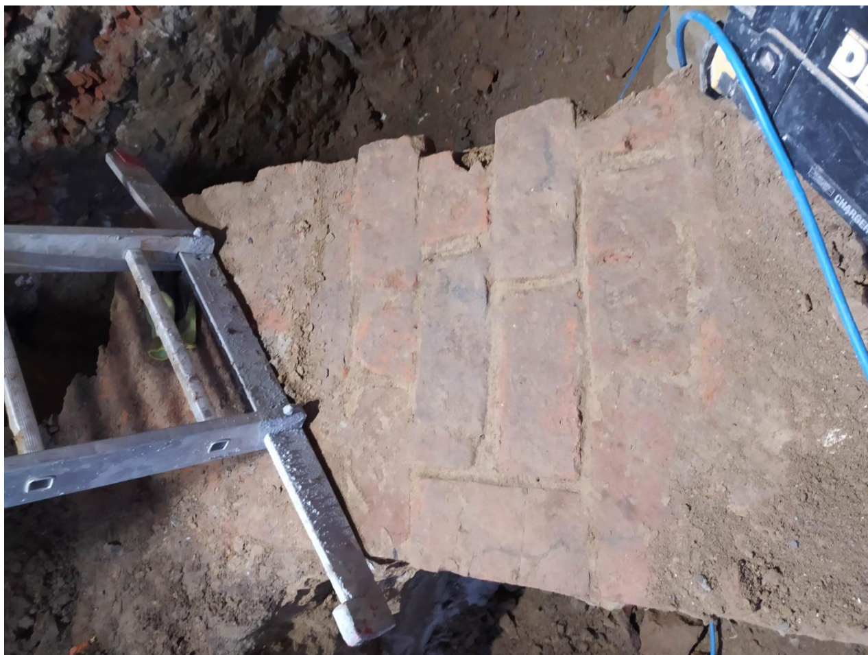
Fot. 27. Poziom ceglanej konstrukcji po zdjęciu wierzchniej, zniszczonej warstwy cegieł.
